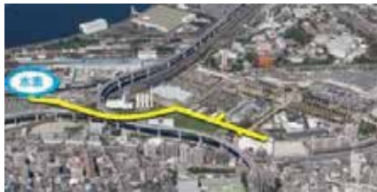
水素パイプライン
