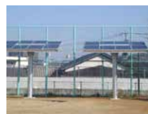
太陽光発電設備（出力3kWの設置例）
