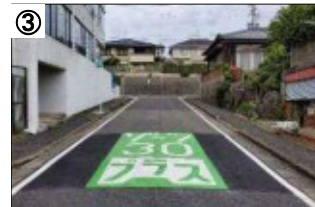
ゾーン30プラス看板・路面表示
