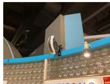
環境ミュージアムに設置中のセンサ
