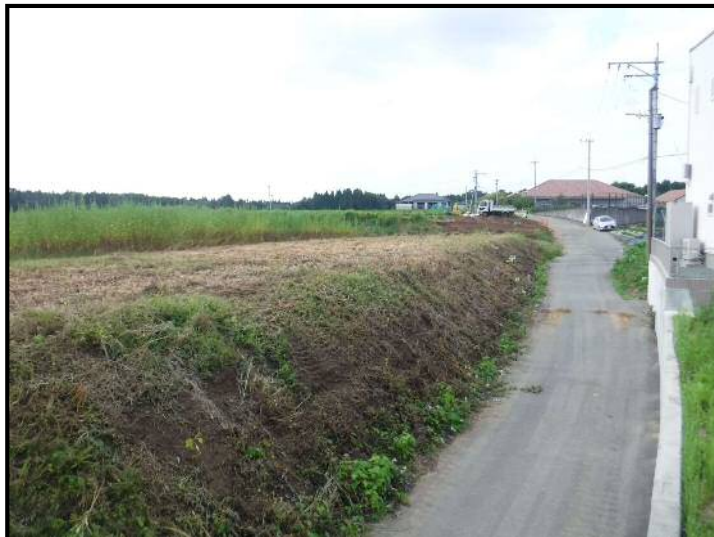
南北線 着工前
