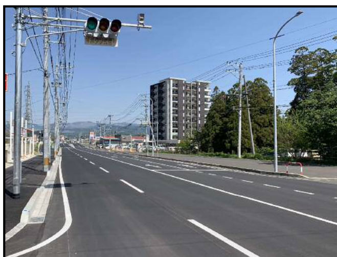
県道熊本高森線の四車線化
