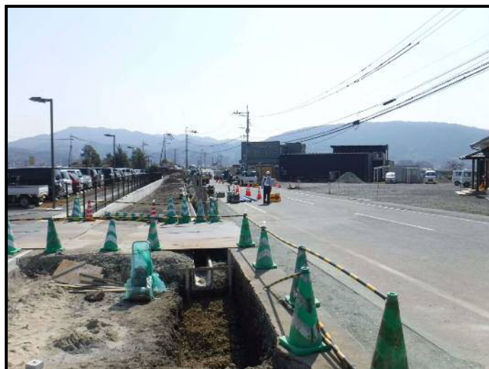
横町線 施工中
