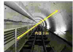
施工状況(シールド工法)
