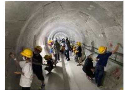
昭和町雨水貯留管管内
