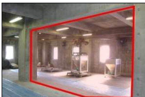
補強前（耐震診断により補強箇所を選定）
