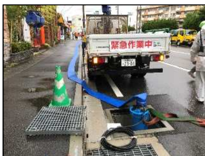
仮設排水ポンプ設置状況
