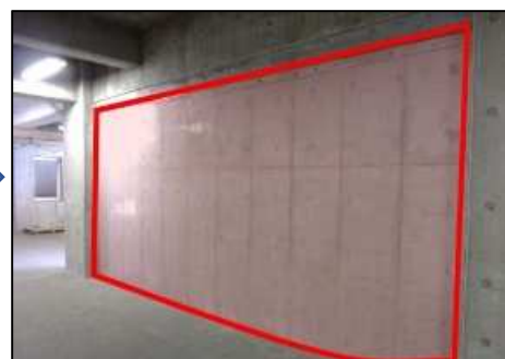
補強後（中空部に耐震壁を設置）
