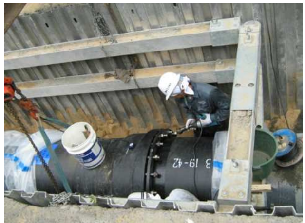
耐震管布設状況
