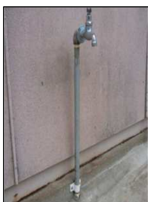
保温チューブ取付前
