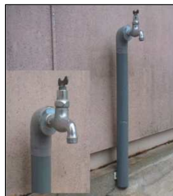
保温チューブ取付後
