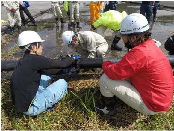
模擬事故訓練（漏水修理）
