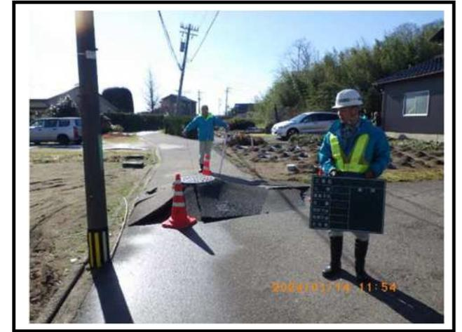
下水道の破損に伴う道路陥没
