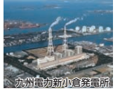
九州電力新小倉発電所
