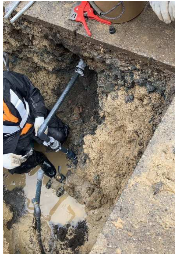
⑤修繕状況 漏水している給水管の部分取替
