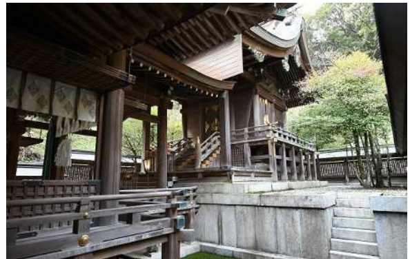
本殿・祝詞舎（南東から）
