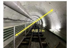
施工状況(シールド工法)
