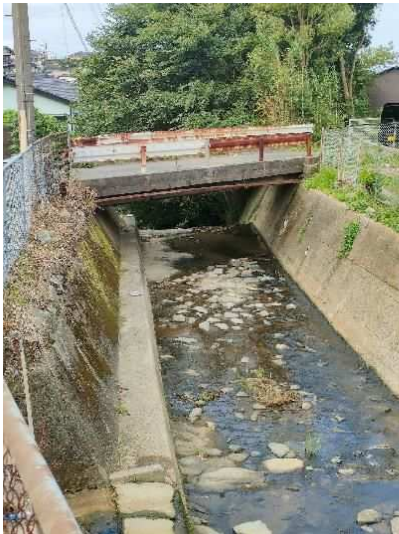
【土地への進入路である橋梁】
