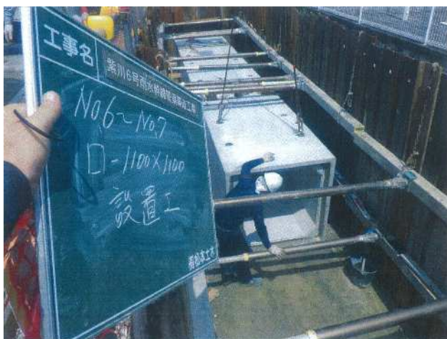
雨水管の整備
