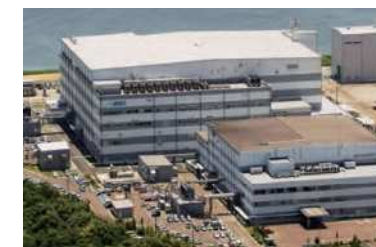
北九州PCB廃棄物処理施設
