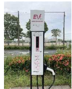
充電インフラ整備
