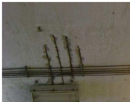
付写真-2.2 鋼材腐食の例
