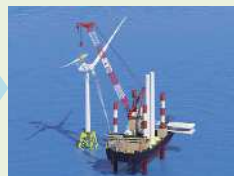
ジャケットの上に、タワー・ナセル・ブレードなどを設置
