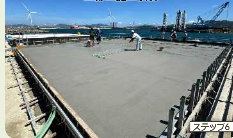
上部工施工状況
