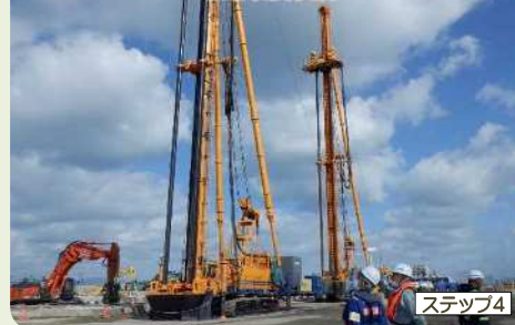
地盤改良状況
