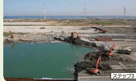
土砂埋戻し状況
