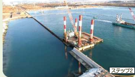
鋼管矢板打設状況
