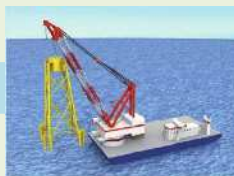
工場で製作したジャケットを洋上に運搬し、設置
