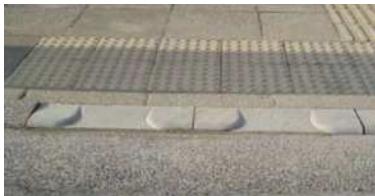
歩道の段差解消
