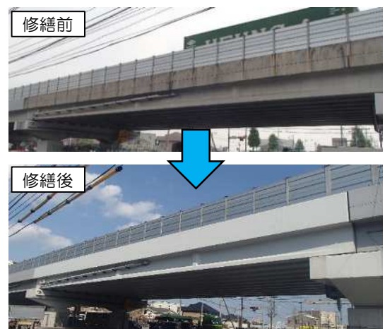
橋梁の長寿命化対策
