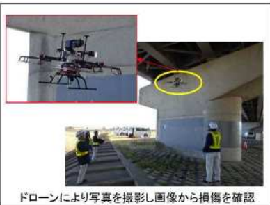
▲ドローンによる道路施設の点検
