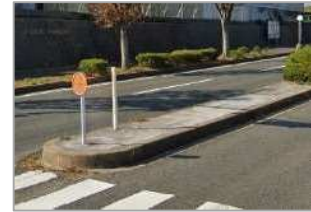
中央分離帯の防草対策▶
