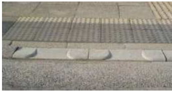
▲歩道の段差解消 出典：鳥取県福祉のまちづくり施設整備マニュアル
