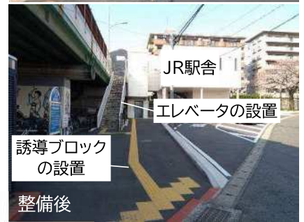
▲安部山公園駅バリアフリー化 (南側広場)
