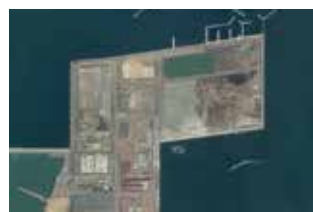
響灘西地区廃棄物処分場
