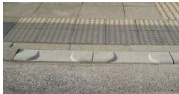
▲歩道の段差解消
