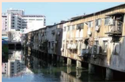
河川上空に張り出した店舗
