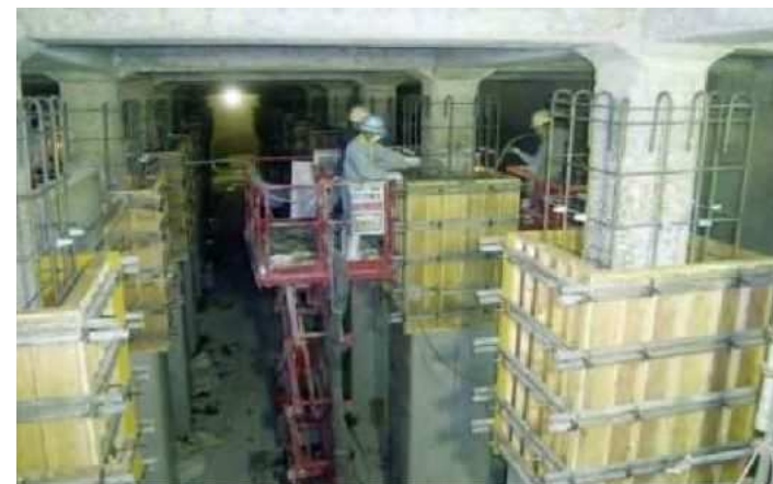
配水池の耐震補強工事 （内面からの壁・柱等の補強）
