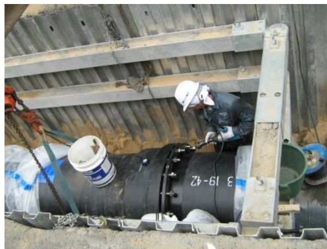
耐震管布設状況
