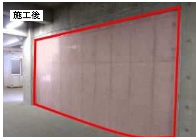
中空部に耐震壁を設置 ポンプ場の耐震化
