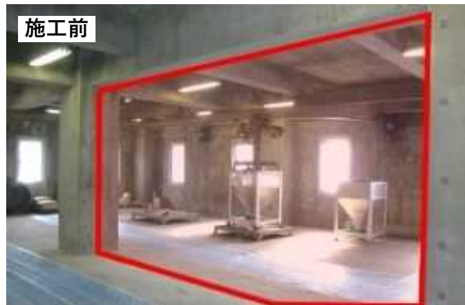
耐震診断により補強箇所を選定
