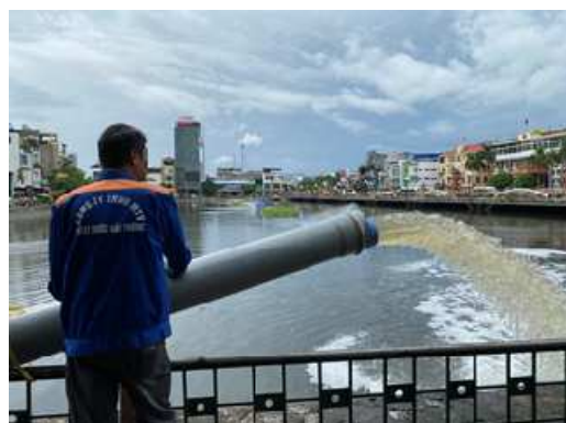
ポンプによる排水訓練
