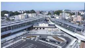
連続立体交差事業 | 2022年高架化完了
