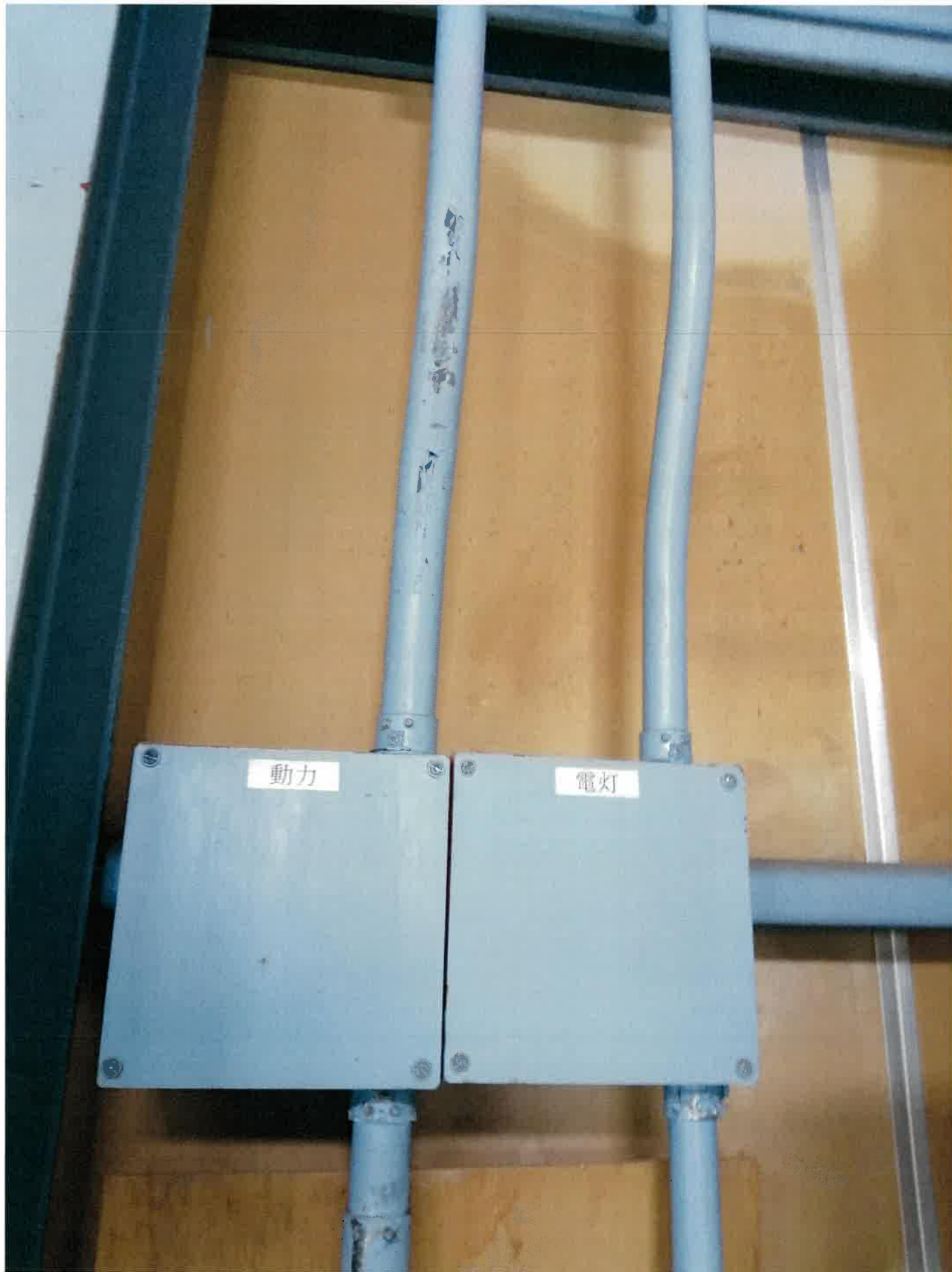
屋内写真（撮影日 令和7年1月30日）
