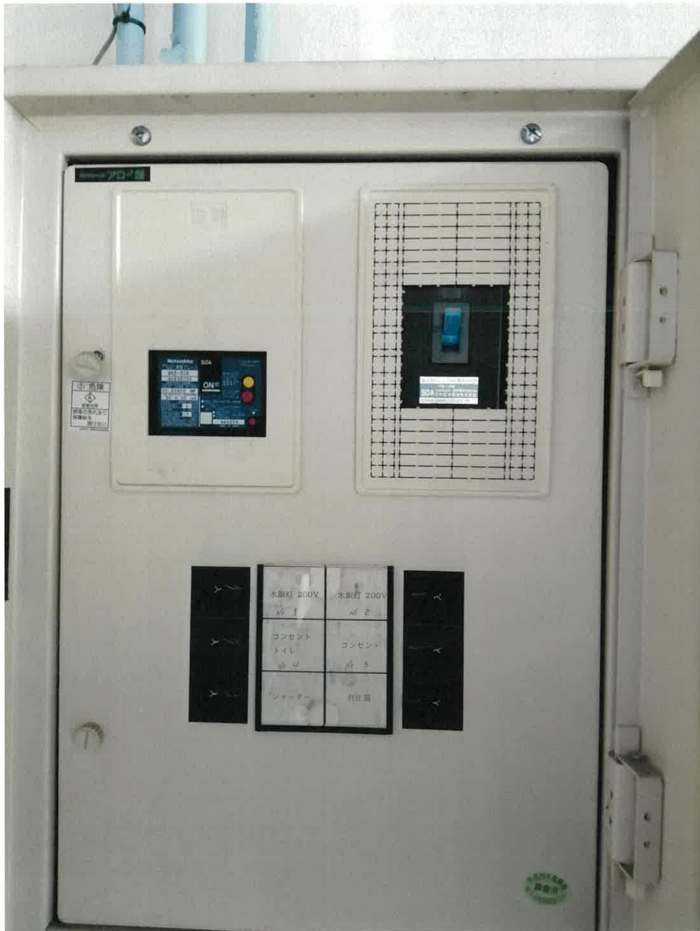
屋内写真（撮影日 令和7年1月30日）
