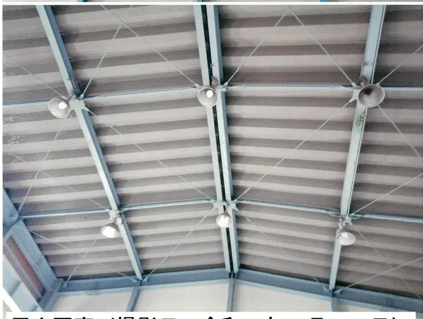
屋内写真（撮影日 令和7年1月30日）
