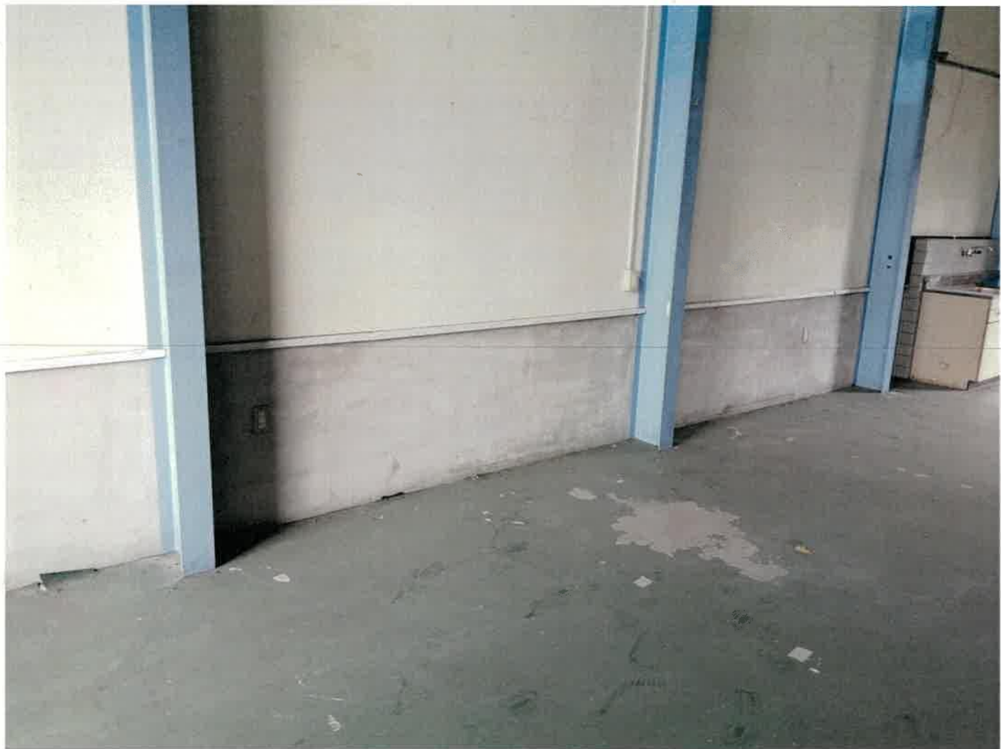
屋内写真（撮影日 令和7年1月30日）
