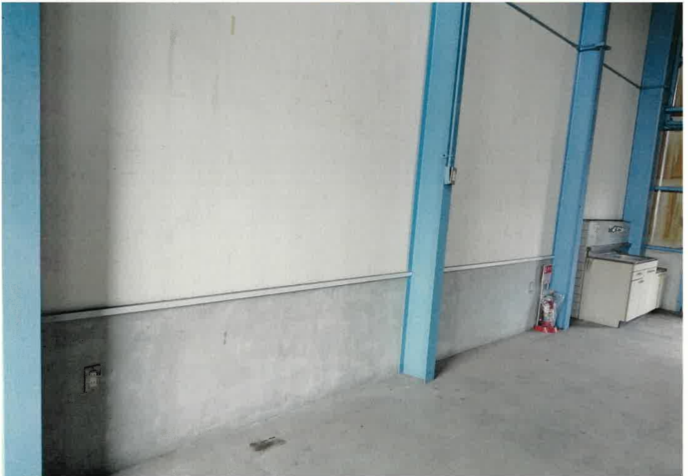
屋内写真（撮影日 令和7年1月30日）
