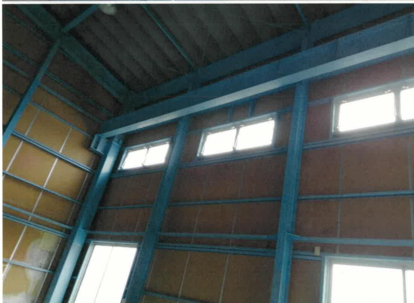
屋内写真（撮影日 令和7年1月30日）
