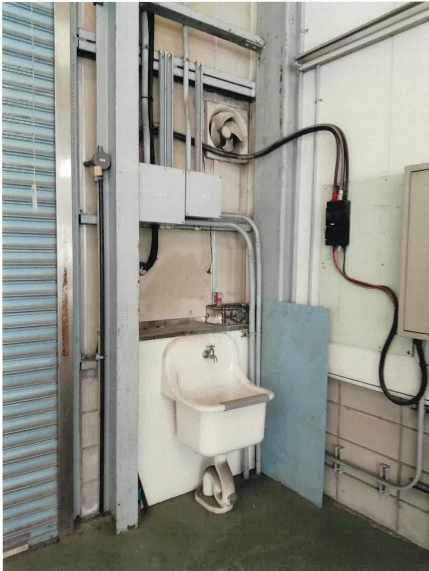
屋内写真（撮影日 令和7年1月30日）
