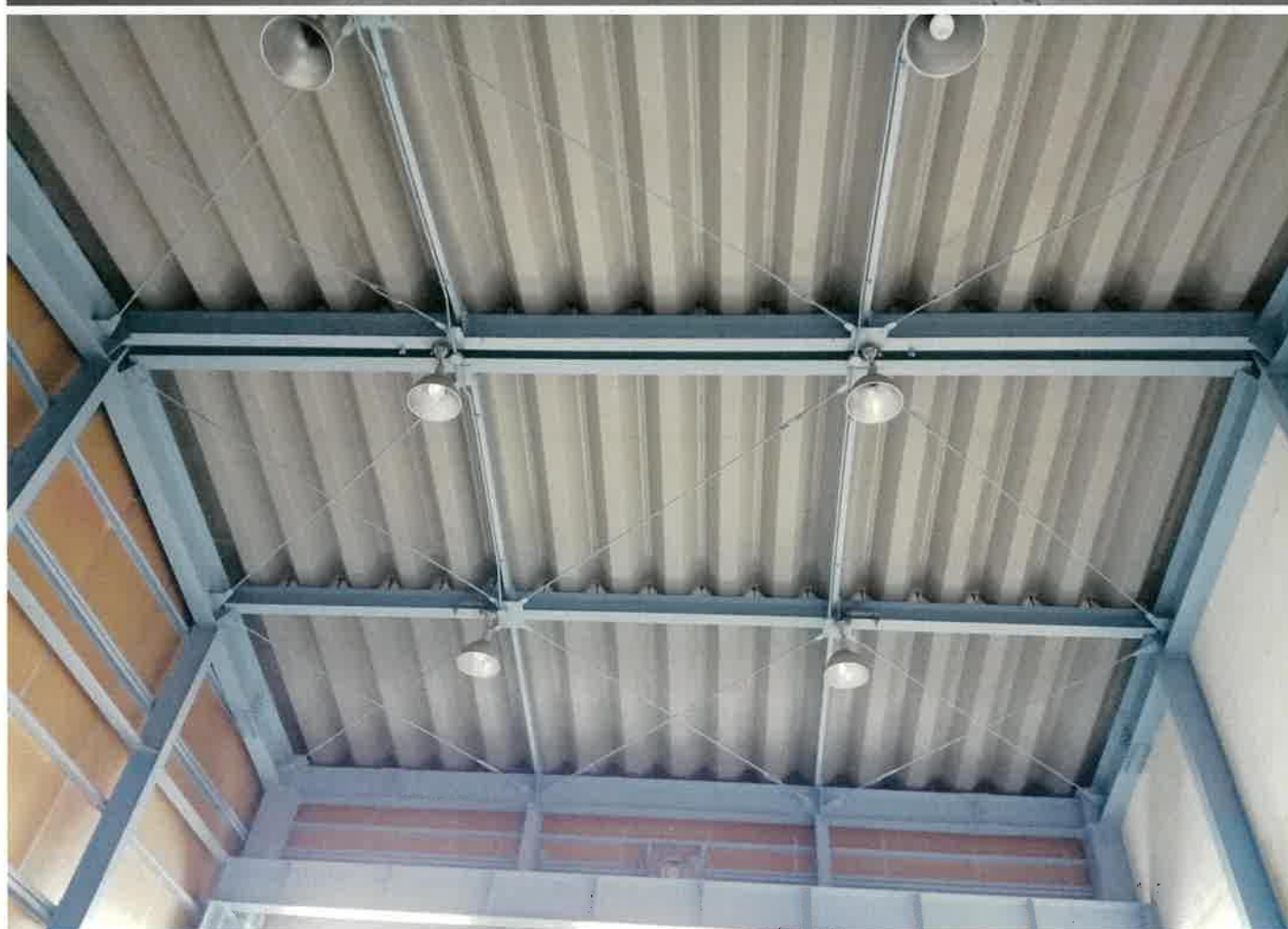
屋内写真（撮影日 令和7年1月30日）
