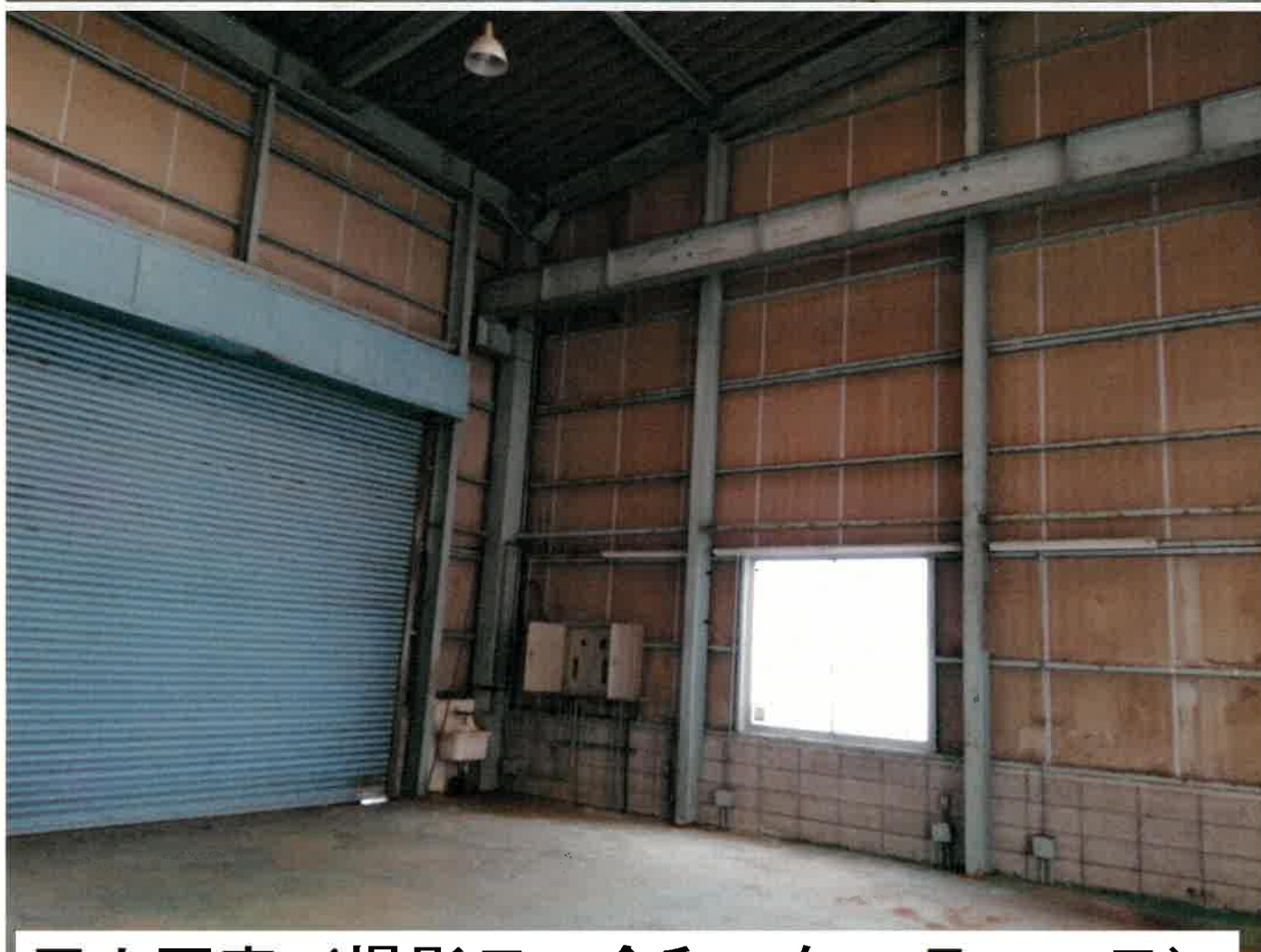
屋内写真（撮影日 令和7年1月30日）
