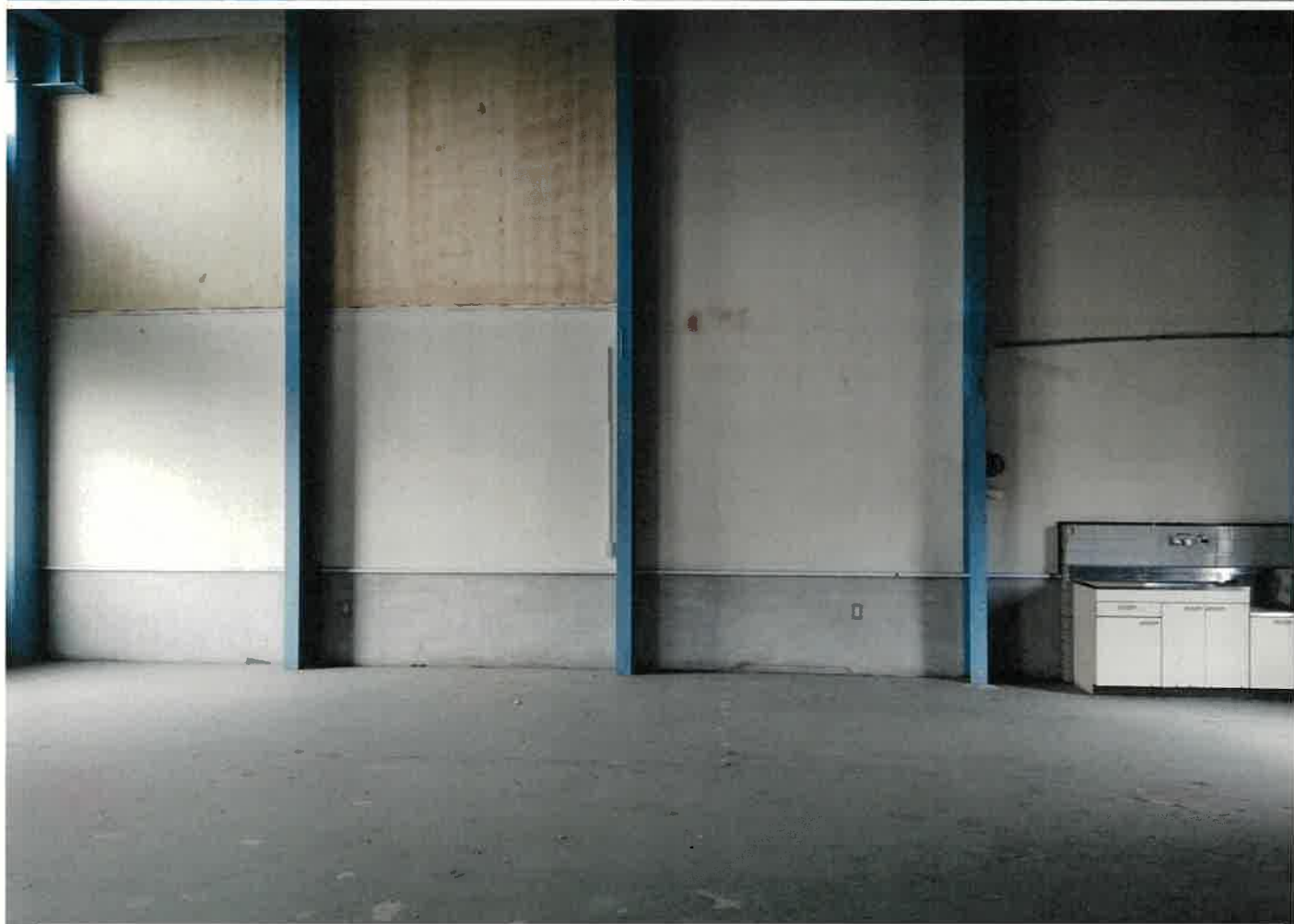
屋内写真（撮影日 令和7年1月30日）
