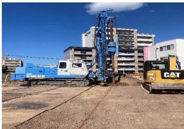
施工状況イメージ
