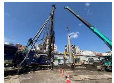
現場施工状況（杭工事）
