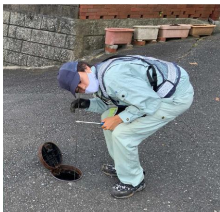
バルブ等の漏水音を音聴棒で調査
