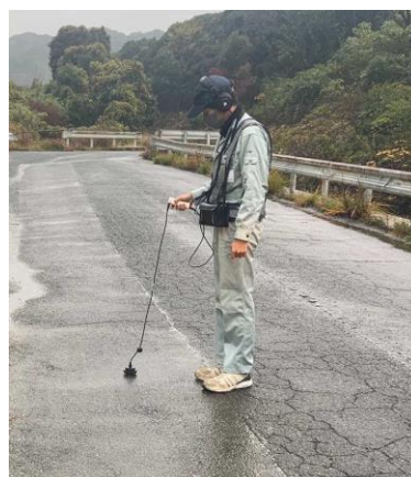
道路上での漏水音聴調査
