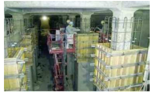
配水池の耐震補強工事 （内面からの壁・柱等の補強）
