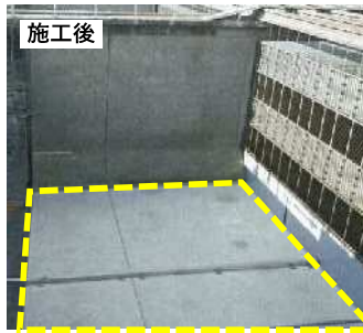
浄水場の耐震補強工事（床版増厚工事）
