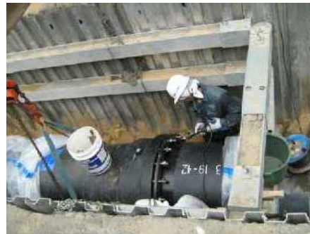
耐震管布設状況
