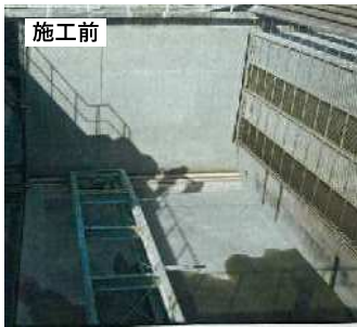
浄水場の耐震補強工事（床版増厚工事）
