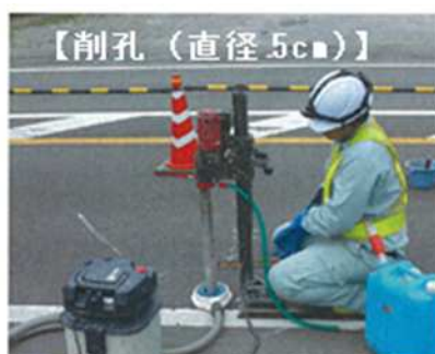
削孔による空洞の確認イメージ (削孔後、カメラで空洞確認)
