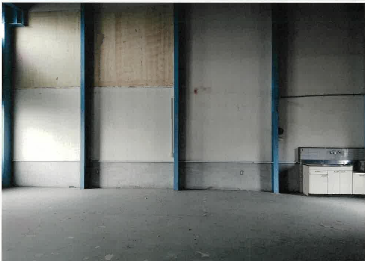
屋内写真（撮影日 令和7年1月30日）
