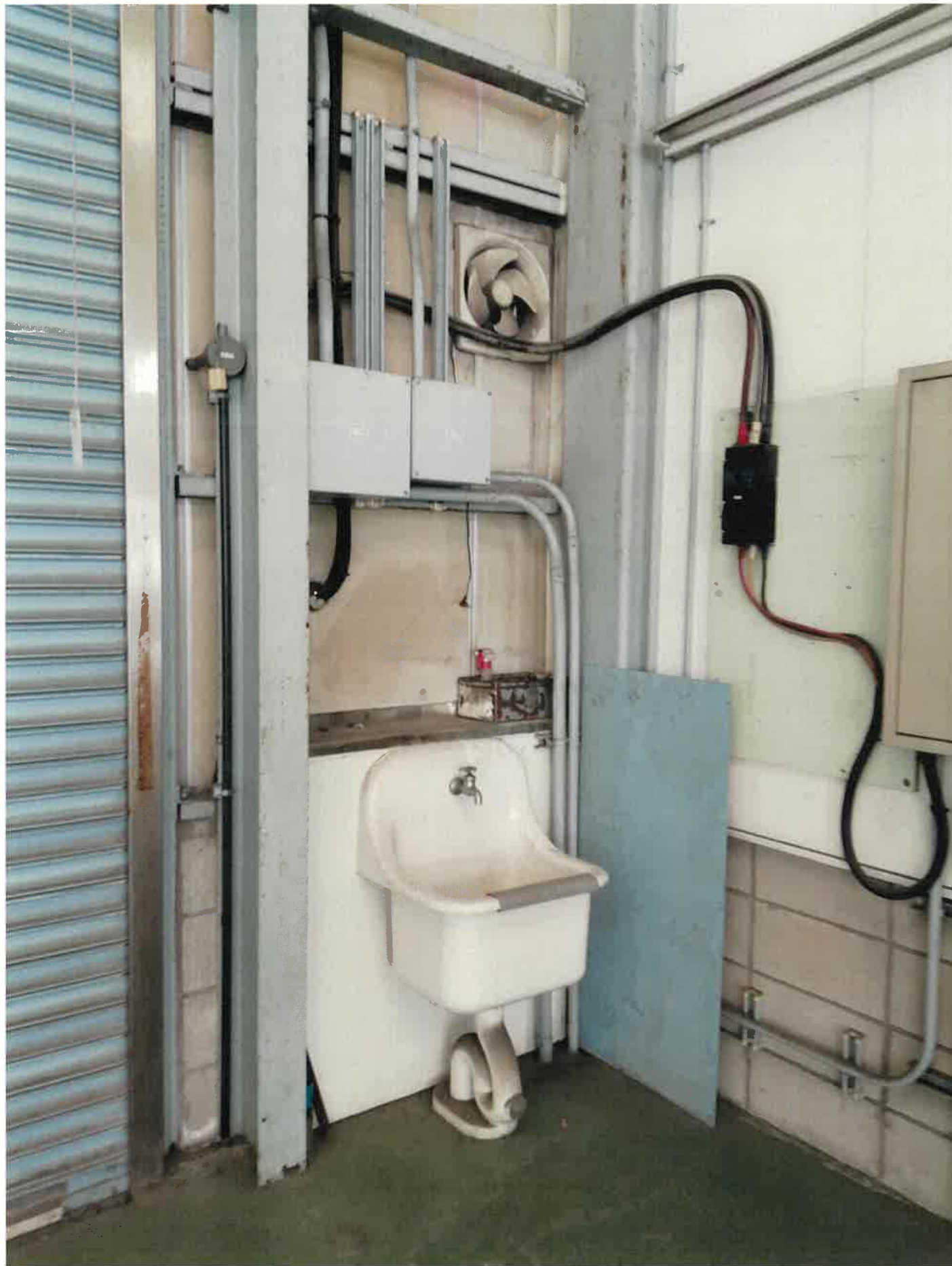
屋内写真（撮影日 令和7年1月30日）
