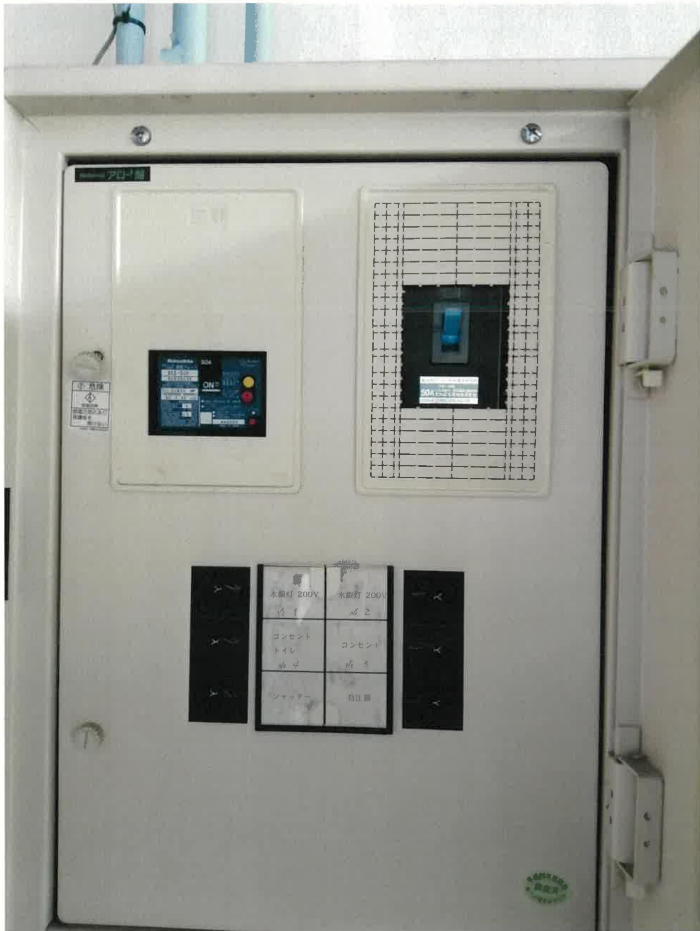
屋内写真（撮影日 令和7年1月30日）
