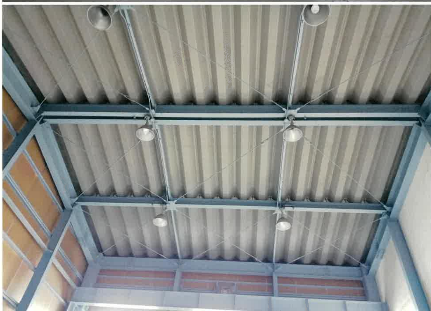
屋内写真（撮影日 令和7年1月30日）
