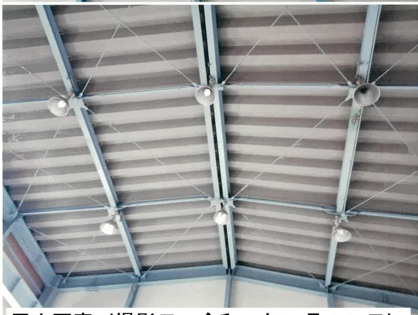
屋内写真（撮影日 令和7年1月30日）
