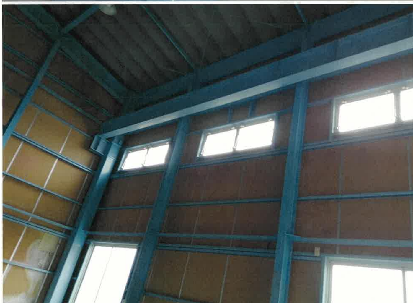
屋内写真（撮影日 令和7年1月30日）
