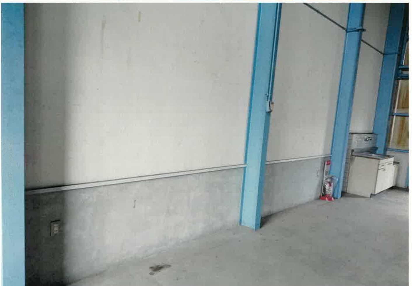
屋内写真（撮影日 令和7年1月30日）
