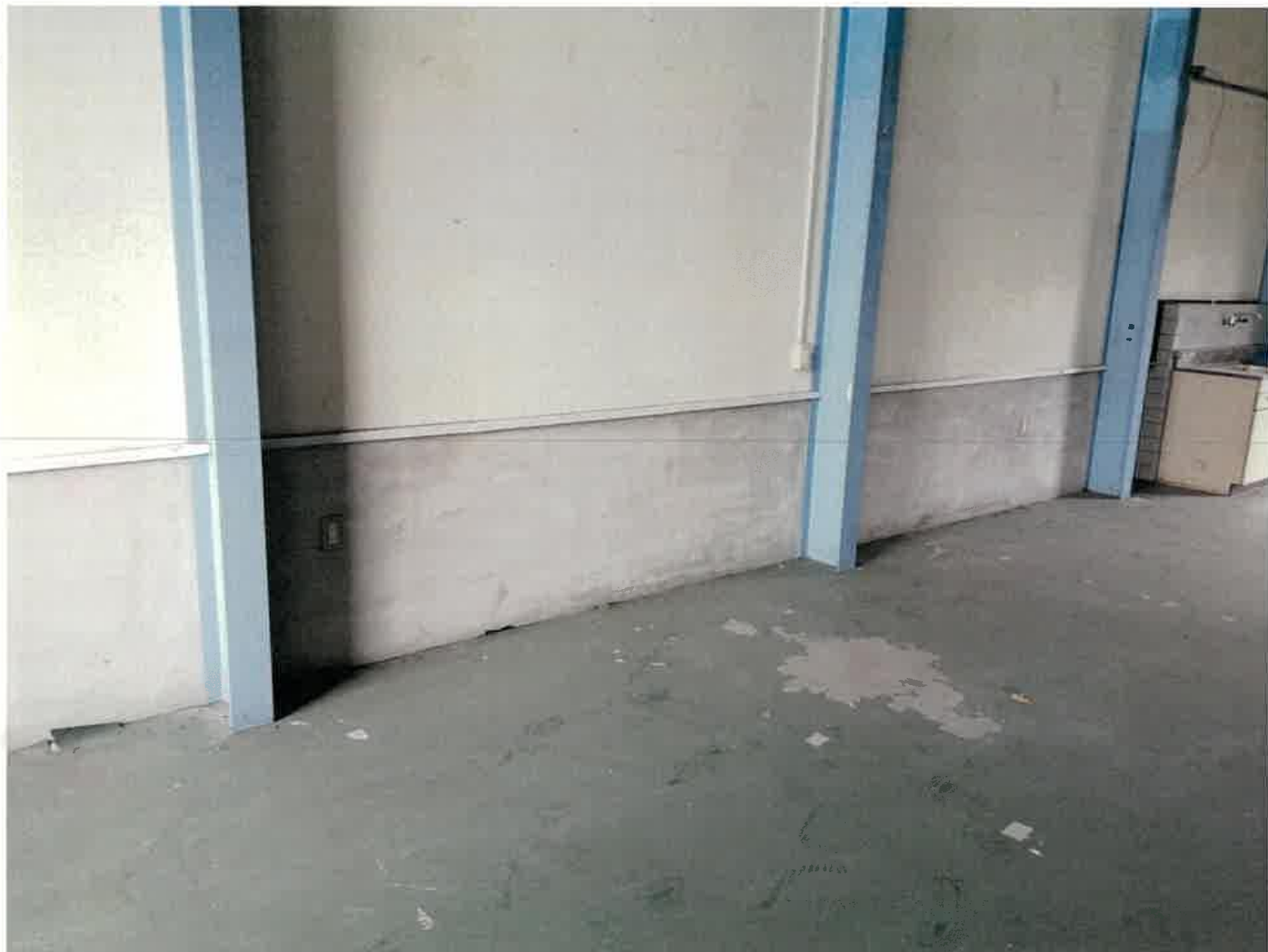
屋内写真（撮影日 令和7年1月30日）
