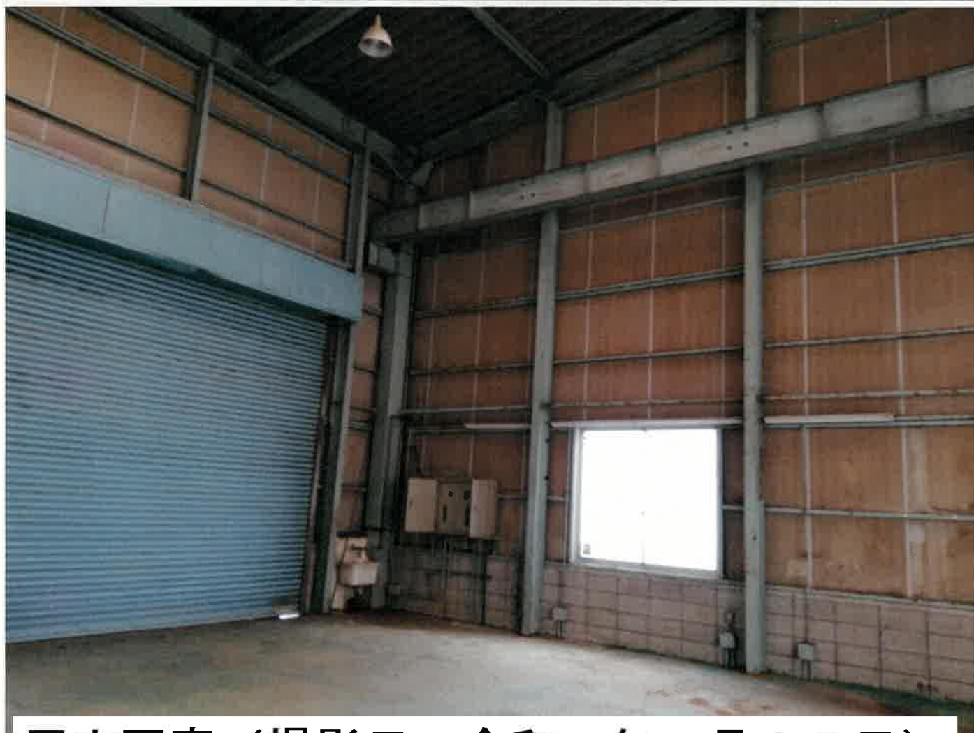
屋内写真（撮影日 令和7年1月30日）
