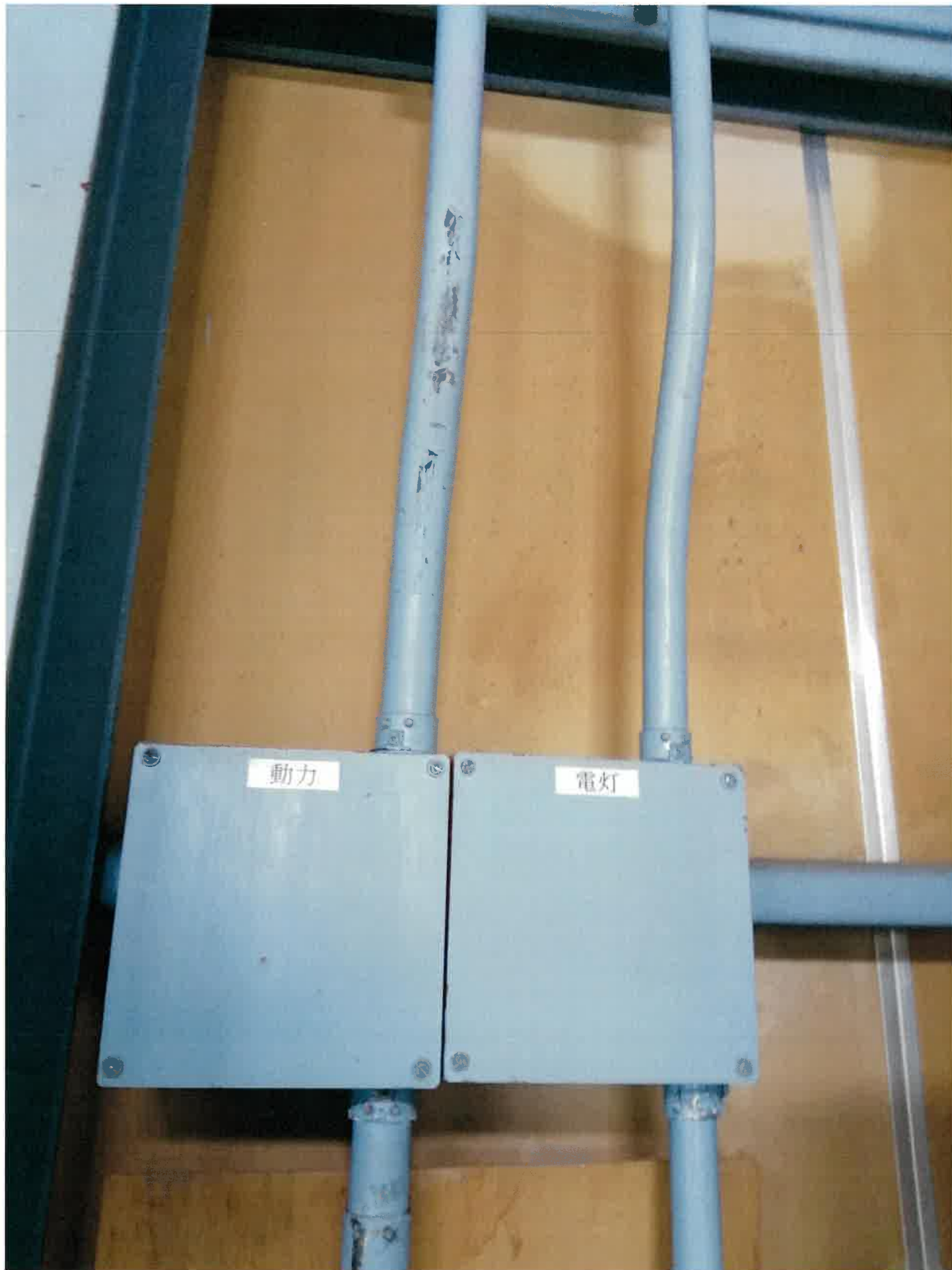
屋内写真（撮影日 令和7年1月30日）
