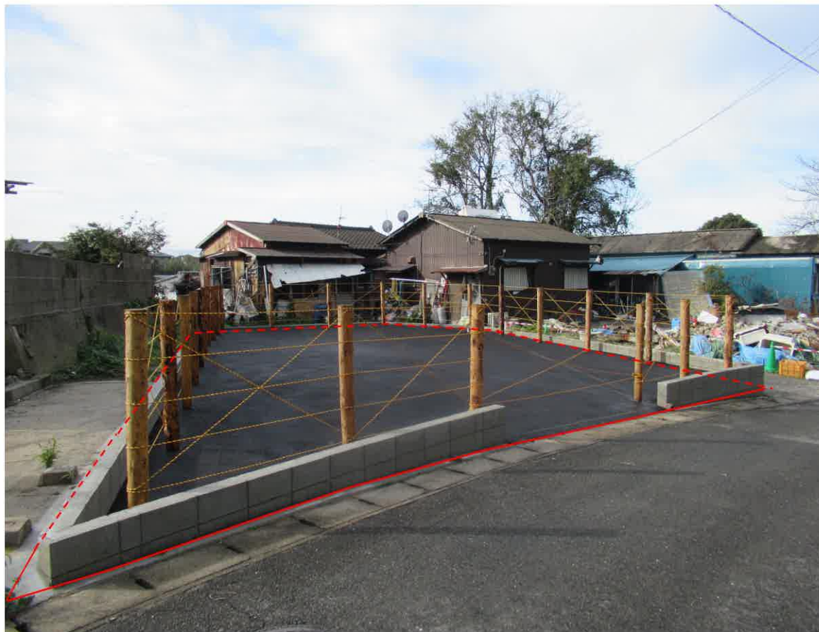
現地写真(北東から撮影) 八幡西区大字笹田 9 8 0 番 9
