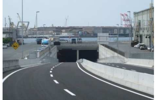
▲若戸トンネル(戸畑側通行口)
