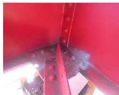
▲若戸大橋の損傷状況(腐食)
