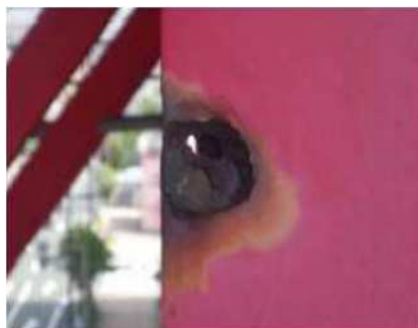
▲若戸大橋の損傷状況(腐食)
