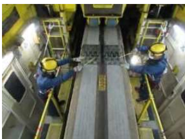
軌道設備点検
