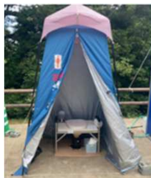
災害用マンホールトイレ
