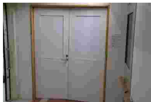
レッドゾーン確保用の扉を廊下に増設
