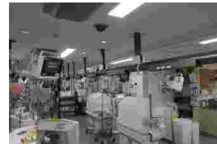
(GCU)天井吊下げ式のサブライユニットは衝突の危険がある
