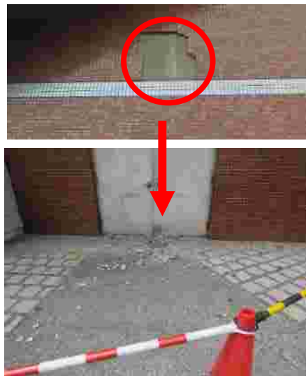
本館外壁タイル落下の状況 (令和3年4月) ※外壁打診調査、補修実施済
