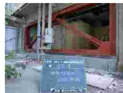
看護師宿舎棟耐震補強工事
