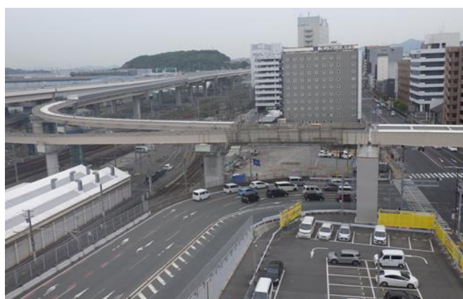
▲黒崎西ランプ（筒井町交差点）の状況（R7.5）
