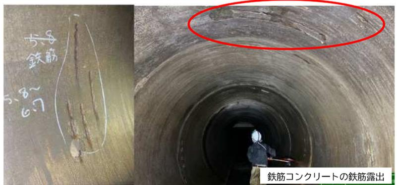
鉄筋コンクリートの鉄筋露出
