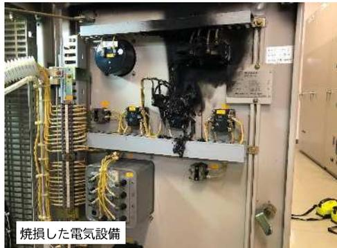
焼損した電気設備
