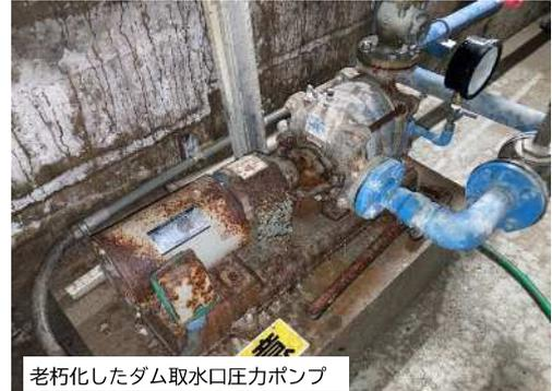
老朽化したダム取水口圧力ポンプ
