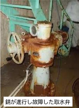
錆が進行し故障した取水弁
