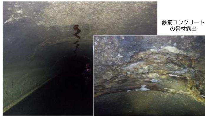
鉄筋コンクリートの骨材露出
