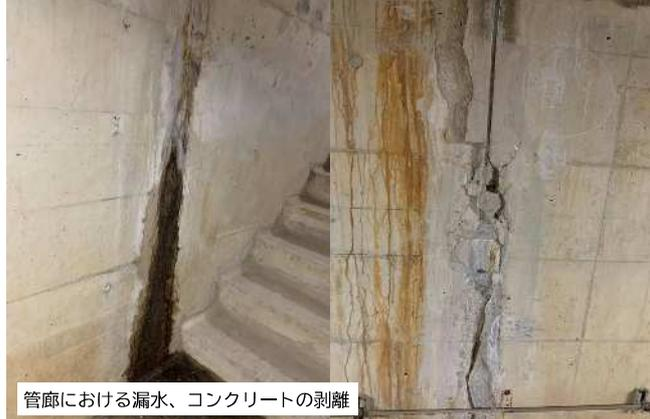
管廊における漏水、コンクリートの剥離
