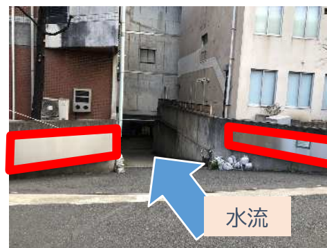
止水板の設置
