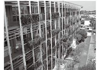
《壁面バルコニーの緑化》緑化プランターを設けることによって、日よけや視覚的な効果をもたらしています。
