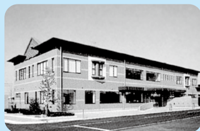
⑦～⑨ 環境センター （写真は⑦ 新門司環境センター） 一般ごみの収集、資源ごみの収集、集団資源回収団体の登録受付、ごみ処理に関する指導などを行っています。
