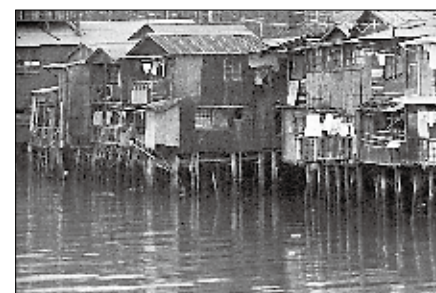
▲紫川沿いに密集する違法建築。汚水は川へ流されました。
