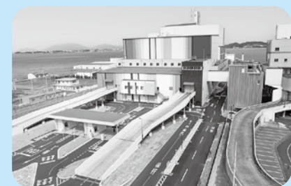
② 日明工場 1日に508tのごみ処理が可能です。 発電出力は18,000kWです。 ☎093-581-7976
