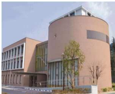
八幡図書館の空調整備
