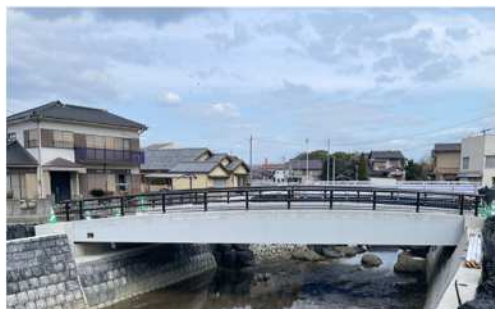
橋梁架け替え上部（相割川）
