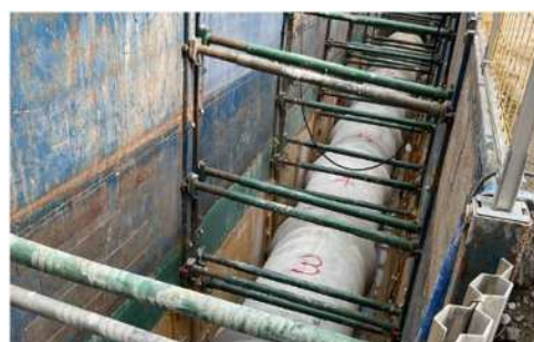
浸水対策整備工事（田原五丁目）
