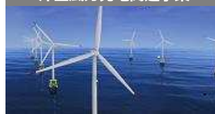
洋上風力発電関連事業
