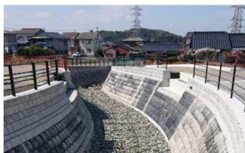
橋梁架け替え下部（割子川）
