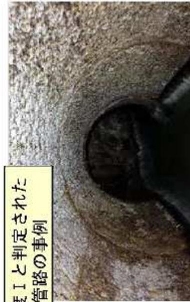
管の腐食から緊急度Ⅰと判定
