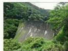
河内貯水池の堰堤
