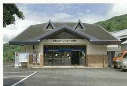
ケーブルカー山麓駅
