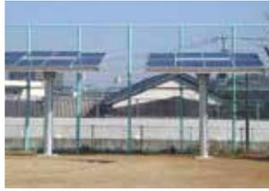
太陽光発電設備（出力3kWの設置例）
