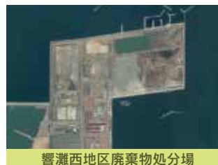
響灘西地区廃棄物処分場
