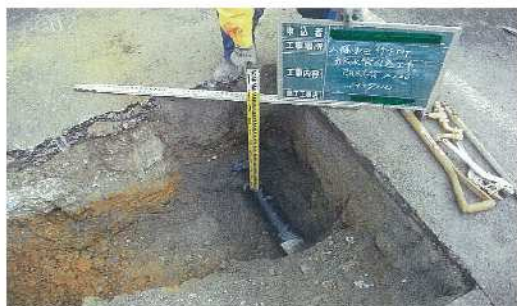
① 既設配水管埋設状況写真
