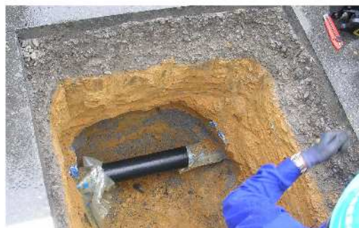
② 既設配水管外観状況写真
