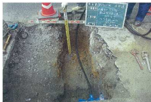
④ 給水管布設状況写真
